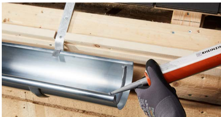
Afbeelding 1.2: Montage van de lijmgoot
