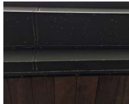
Voorbeeld van zoutafzetting op de onderzijde van een overstek en een dakgoot
