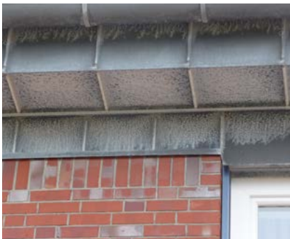
Voorbeeld van zoutafzetting op de onderzijde van een overstek en een dakgoot
