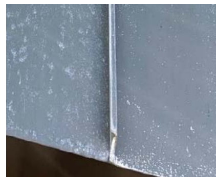
Voorbeeld van zoutafzetting op de felsen en druipkant van gevels
