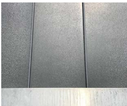
Voorbeeld van zoutafzetting op de felsen en druipkant van gevels
