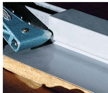
Afbeelding 2.8: vastzetten van de kap met een popnagel
