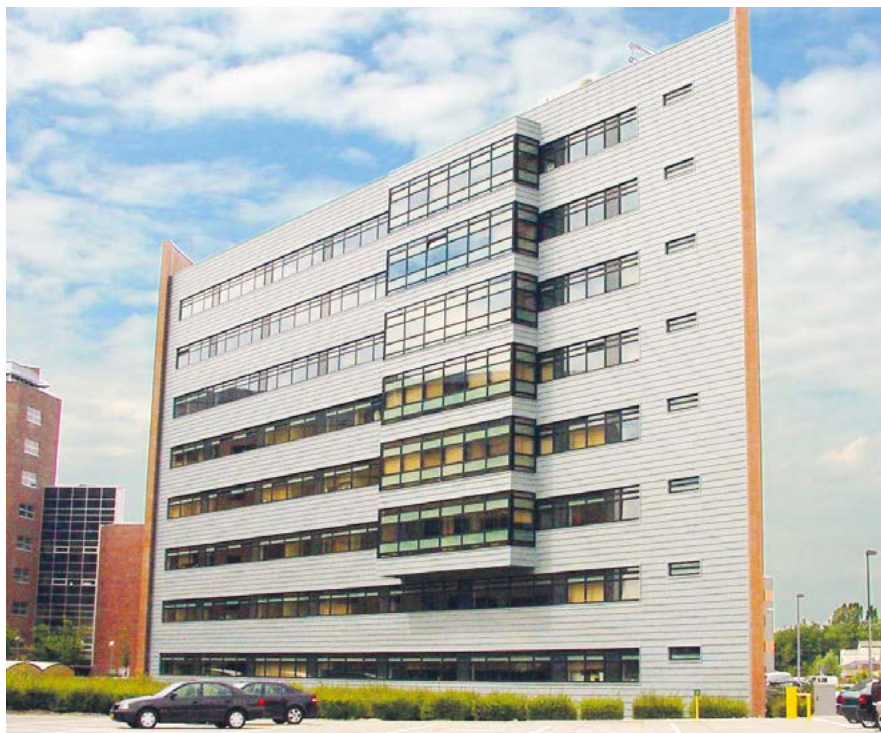
Afbeelding 1.17: felsgevel, horizontaal
