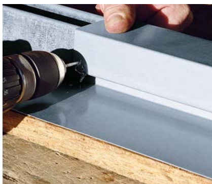
Afbeelding 2.7: voorbereiden van de klik-roefkap en klik-klang
