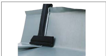
Opkanten met een afgeronde zettang
