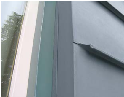
Detail 32: kozijnaansluiting dagkant
