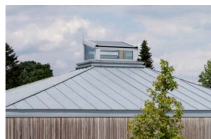
Afbeelding 1.5: dubbele staande fels
