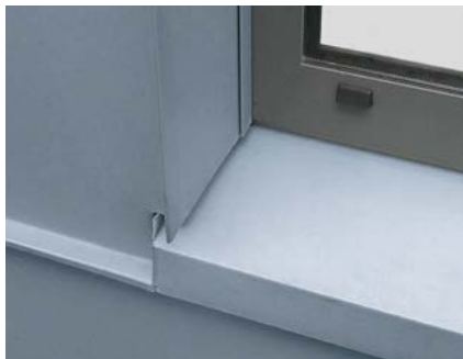
Detail 28: kozijnaansluiting onder
