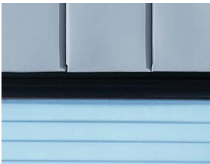
Detail 22: kozijnaansluiting boven
