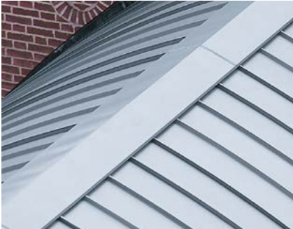
Detail 6: geventileerde nok
