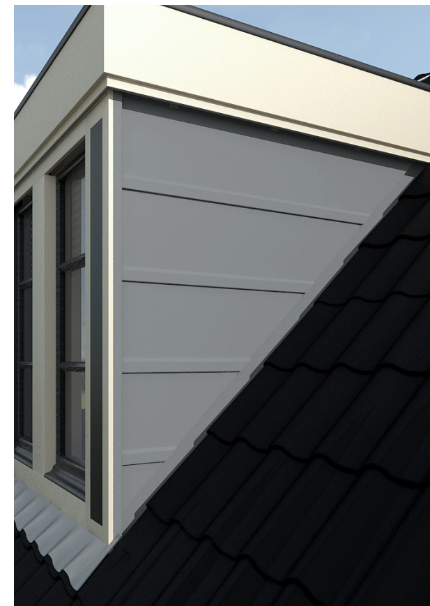
Plaatsen front en dakpannen
